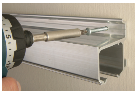
Paso 1: Instale el riel para montaje en pared.
